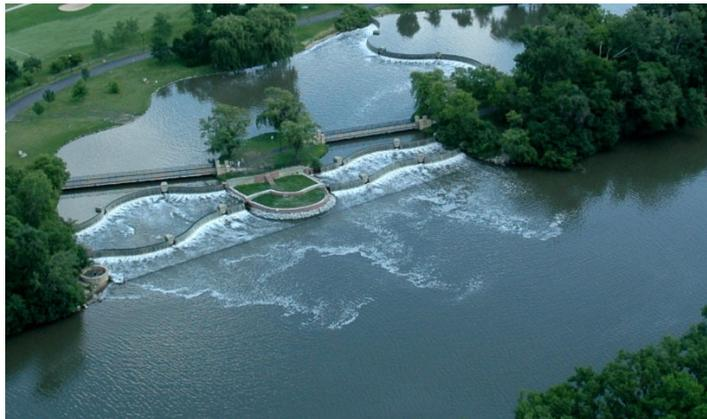
Figura 98. Infraestructura de reaireación y enfriamiento de agua: Sidestream Elevated Pool Aeration (SEPA) stations.
